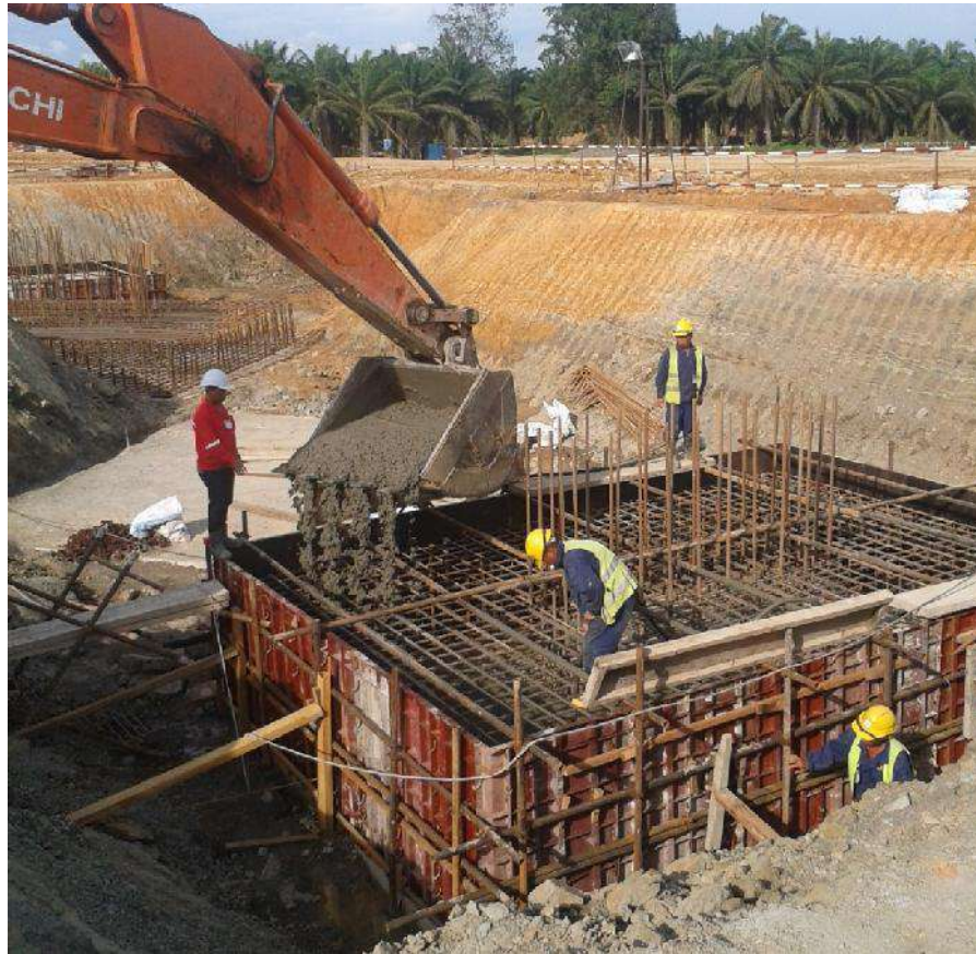
熔炉地基第一次混凝土浇灌 - 2014年4月
